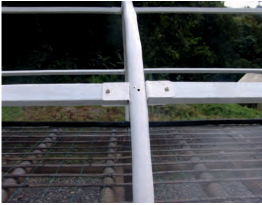
Figura 6. Acople de listones de madera a los arcos metálicos de la cubierta del secador.
