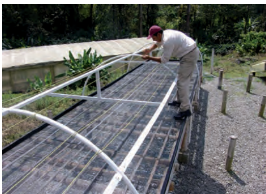
Figura 8. Colocación de cuerdas para soportar el plástico de la cubierta.
