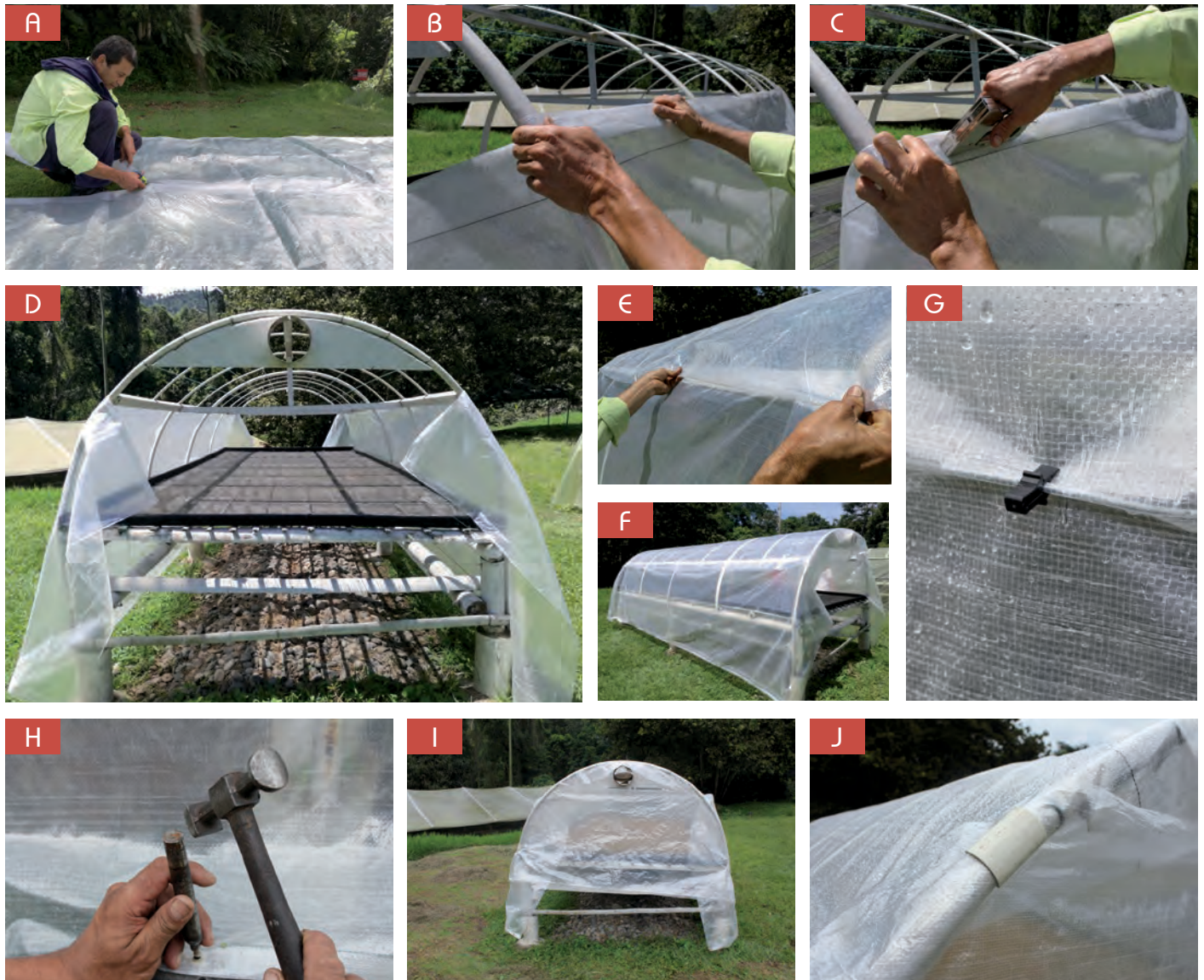
Figura 9. Detalles para la colocación del plástico reforzado en el secador solar tipo túnel. Corte del plástico (A), doblez del plástico de la ventana lateral (B), fijación del plástico al listón utilizando la grapadora (C), secador con las dos ventanas laterales (D), fijación del plástico de la cumbre del secador (E), secador completo (F), temple de las ventanas laterales (G) y ventana frontal (H), vista frontal del secador (I), accesorios (J).
