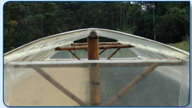
Figura 6. Espacio para la circulación del aire.
