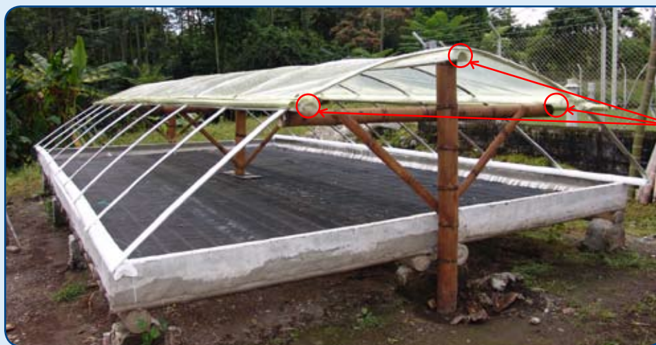
Figura 1. Estructura general de soporte, con tres vigas y tres soportes en cruz.
