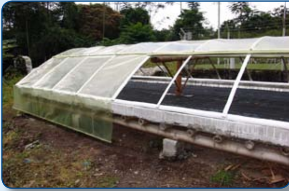
Figura 4. Compuertas o tapas laterales enrollables
