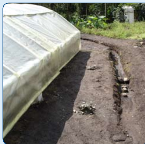
Figura 7. Drenaje para desviar el agua de escorrentía.
