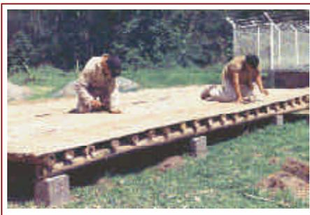
Figura 6. Piso en entramado de guadua, con esterilla
