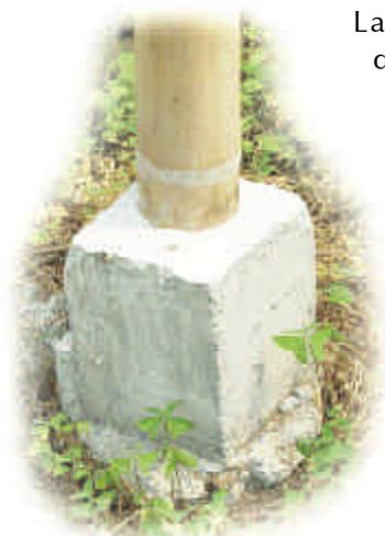
Figura 4. Columna en guadua revestida en concreto
