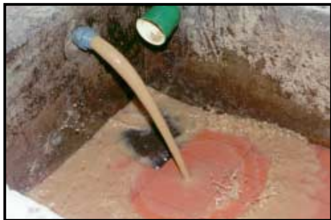
Figura 6. Drenaje del agua del primer enjuague (I).
